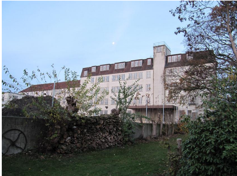
Das Hansa-Gebäude von der Rückseite
